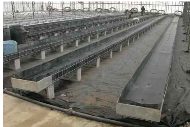
Resim: Bençlerin kafesler içine yerleştirilmesi
