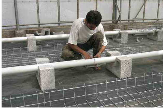
Resim: Topraksız kültürde bençlerin (Substrat yataklarının) altına drenaj kanalı döşenmesi
