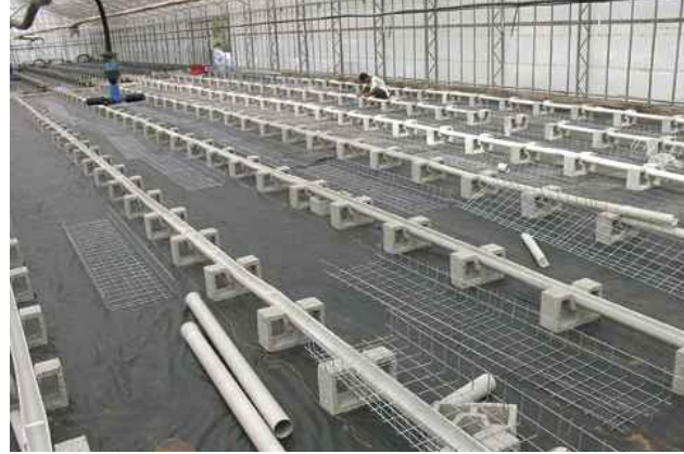
Resim: Bençler seranın içerisine tabanda tesviye ve sıkıştırma yapılarak belli bir meyil ile yerleştirilmekte böylece yatak içinde göllenme önlenmektedir
